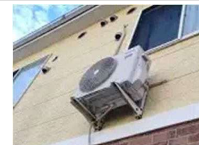
室外機の高所移設
